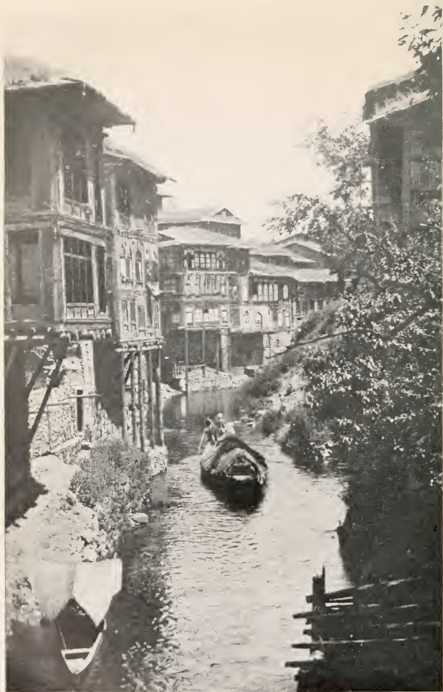
THE MAR CANAL, SRINAGAR.
